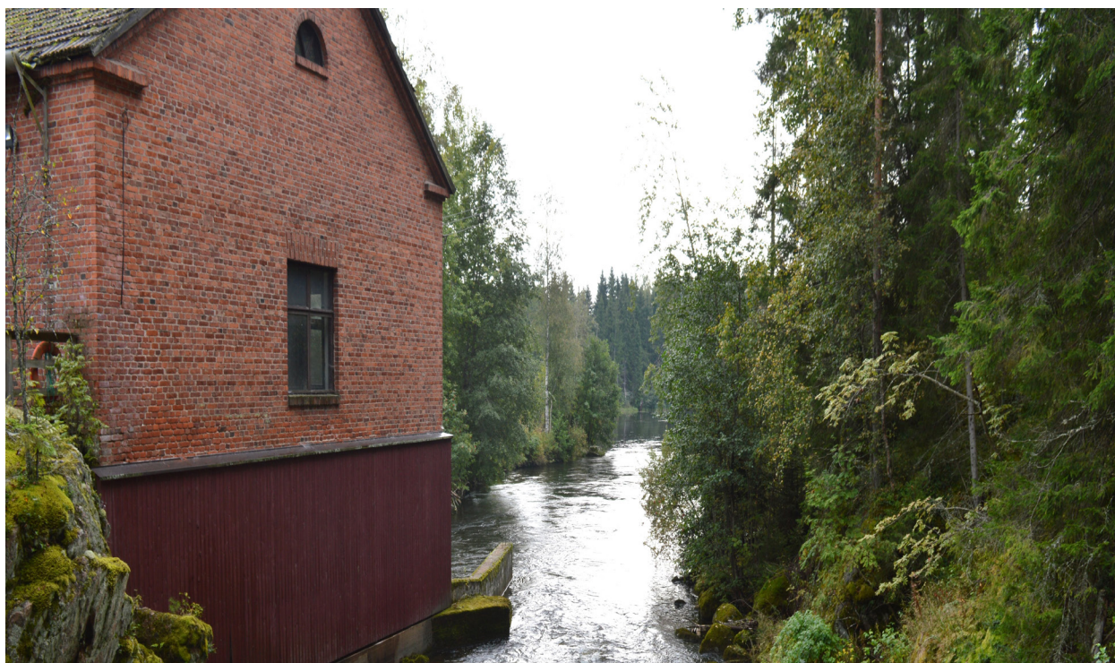
Hiitolanjoki, Lahnasenkosken voimala, Rautjärvi, kuva Etelä-Karjalan liitto
