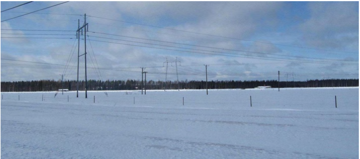
Maaselänkangas-Lammaslamminkangas kuva 1 ilman tuulivoimaloita.
