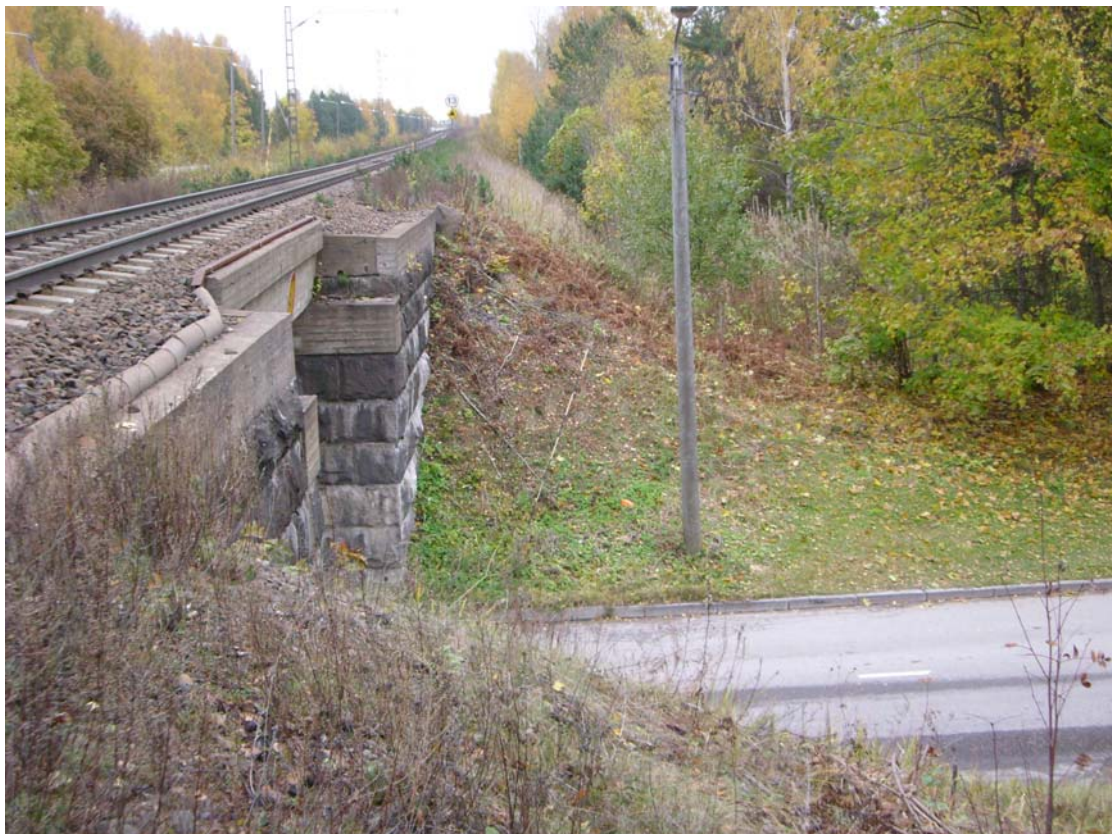
Kuva 6 Hakalintien alikulkusilta lännestä katsottuna
