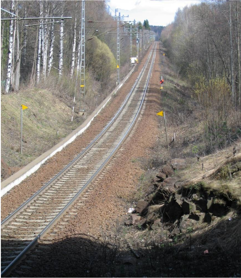
Kuva 13 Ratalinja kulkee Vuoksenniskan kohdalla osittain maaleikkauksessa, taajaman keskusta on vasemmalla metsikön takana
