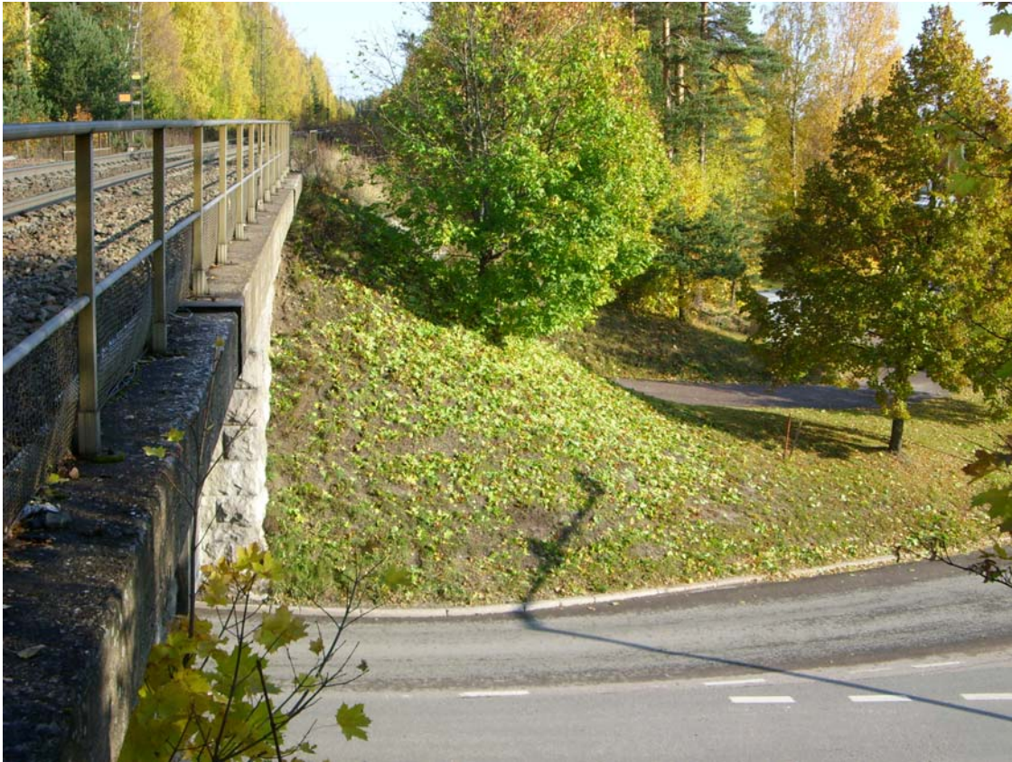
Kuva 7 Näkymä Standertskjöldinkadun sillalta alikulun itäpuolelle, jonne uusi asema sijoittuisi. Alikulun itäpuolella on erillinen kevyen liikenteen alikulku.
