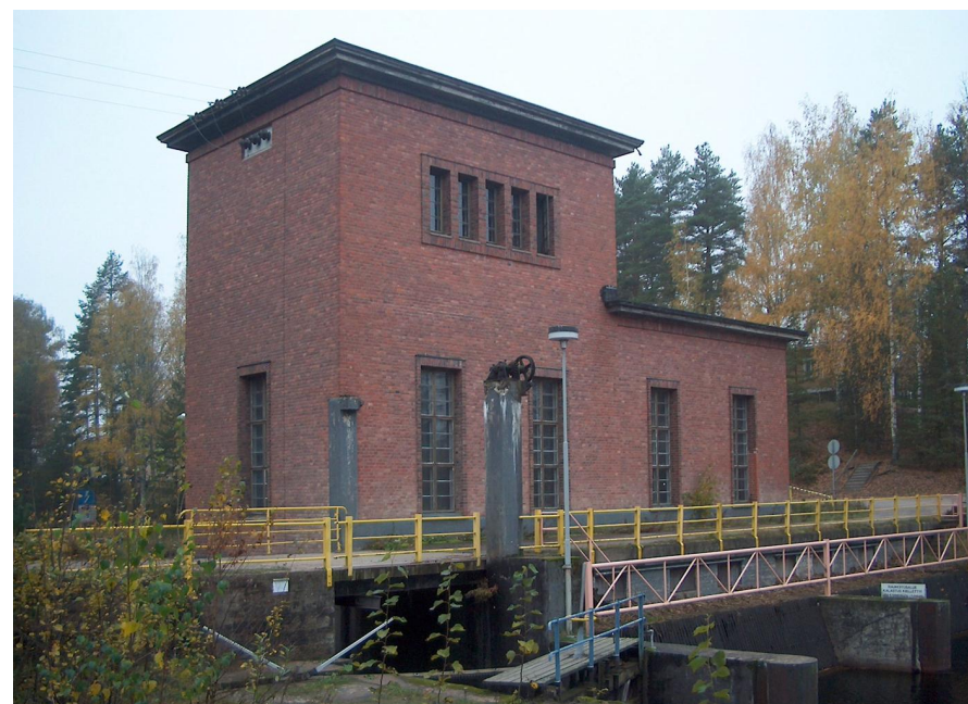
Vehkataipaleen pumppuasema. Kuva Pöyry Environment Oy.
