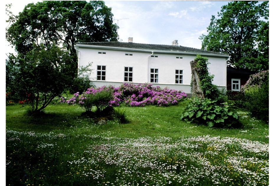
Alueilla, joilla on arvokasta vanhaa rakennuskulttuuria ja omaleimaisuutta, on uusi rakentaminen sopeutettava siihen niin, että saataisiin säilymään kunkin alueen ominaisimmat ja arvokkaimmat piirteet. Ristimäki, Parikkala. Kuva Arto Hämäläinen 1986.
