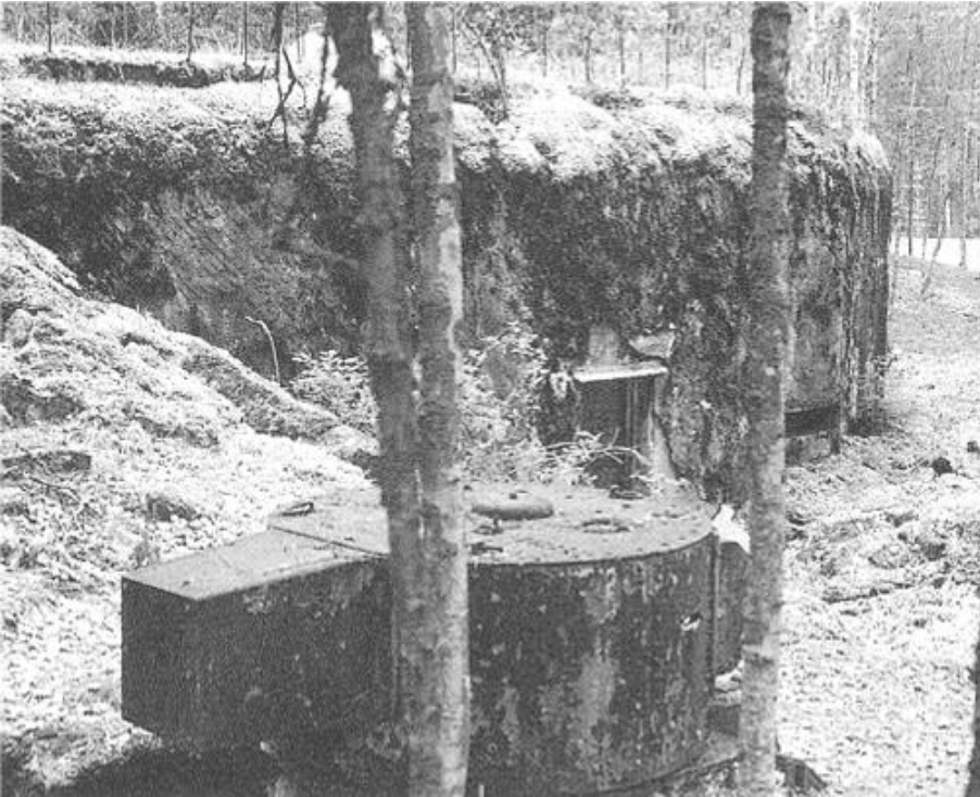
Teräsbetonikorsu Luumäen Askolassa. Etualalla kesällä 1944 panssarivaunun tornista rakennettu teräspesäke. (Länsivaara ja Tolmunen 1994.)
