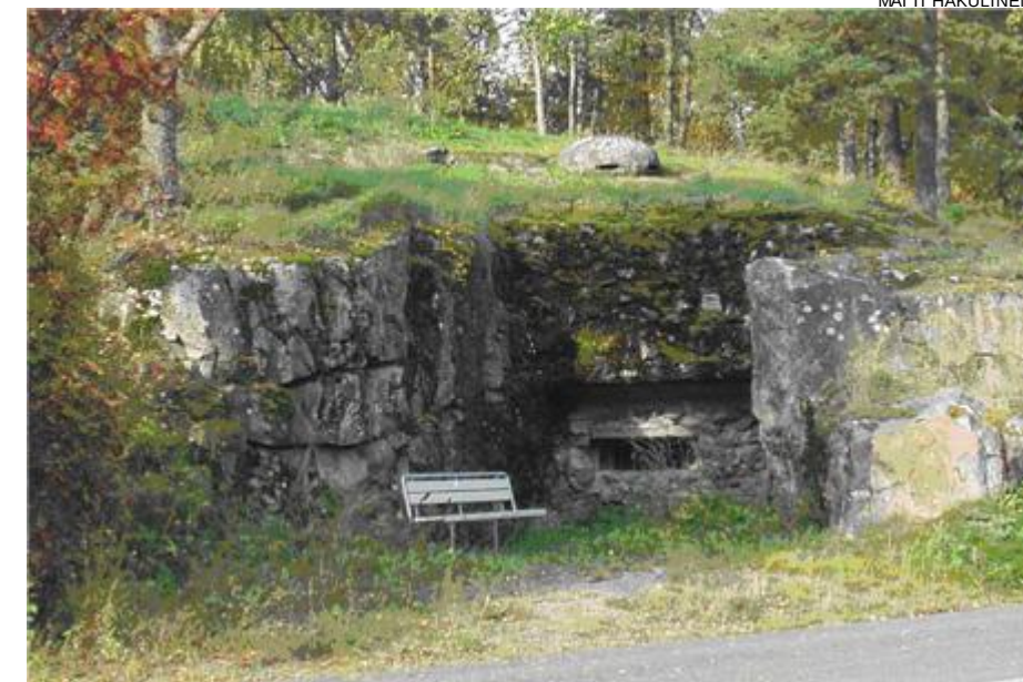
Kuva 20. Teräsbetonikorsu Lappeenrannan Voisalmessa
