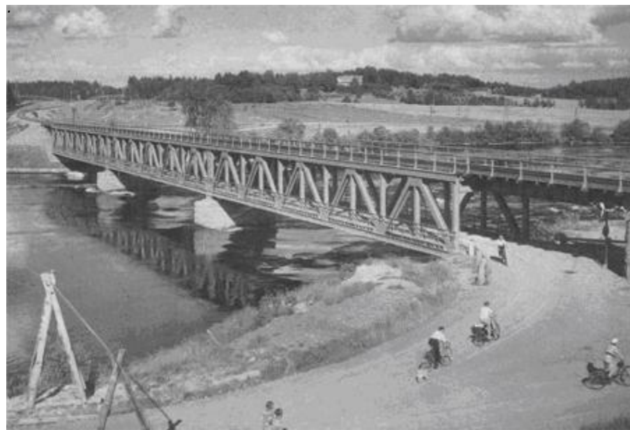
Kuva 14. Merkittävimmät maantiesillat ylittävät Saimaan kanavan Lappeenrannassa ja Vuoksen Imatralle. Mansikkakosken rautatie- ja maantiesilta (RIL 2004)
