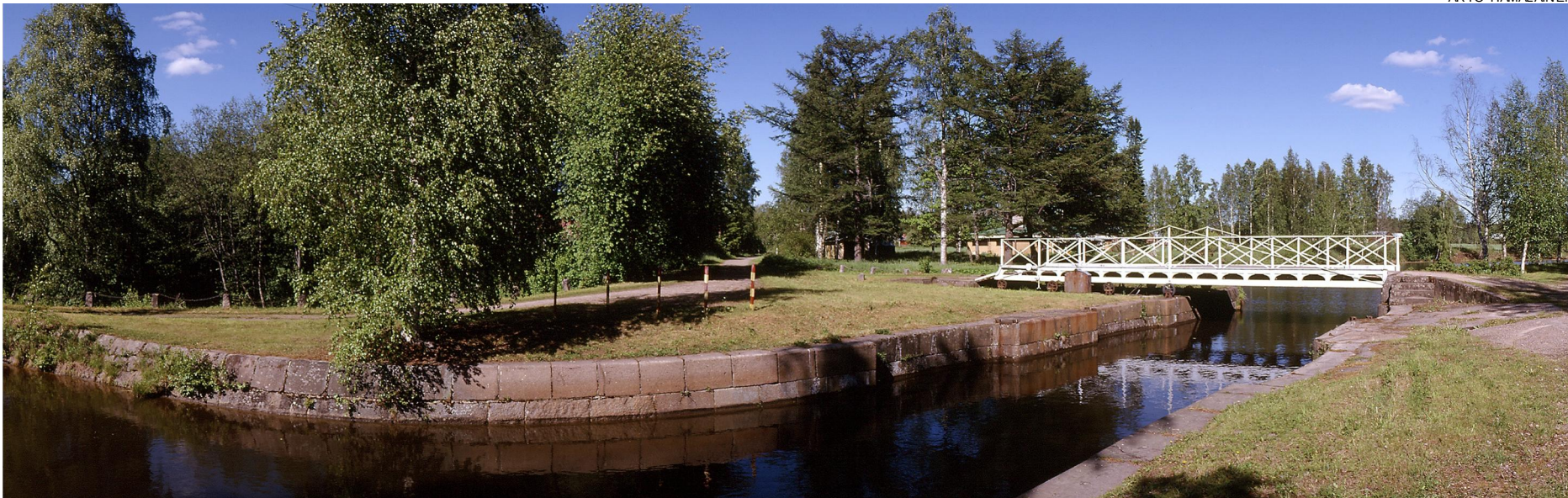
kuva 7: Suomen ensimmäiset valurautasillat rakennettiin Saimaan kanavalle. Vanhaa kanavaa Lappeenrannan Kansolassa.
