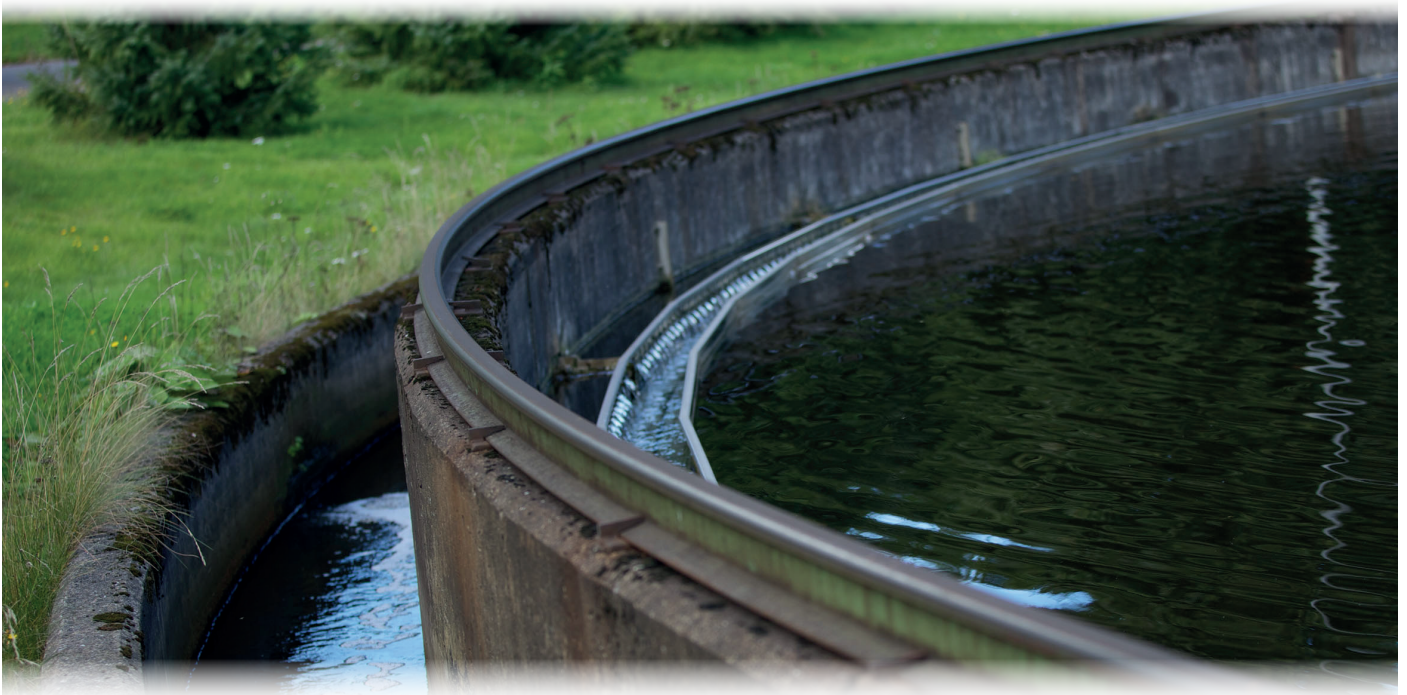
Kuva Toikansuon jätevedenpuhdistamo, Lappeenrannan Energia Oy.
