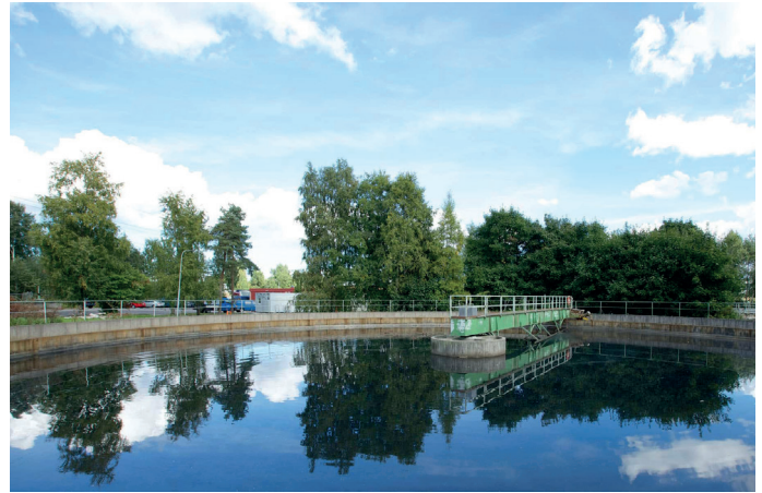
Kuva Toikansuon jätevedenpuhdistamo, Lappeenrannan Energia Oy
