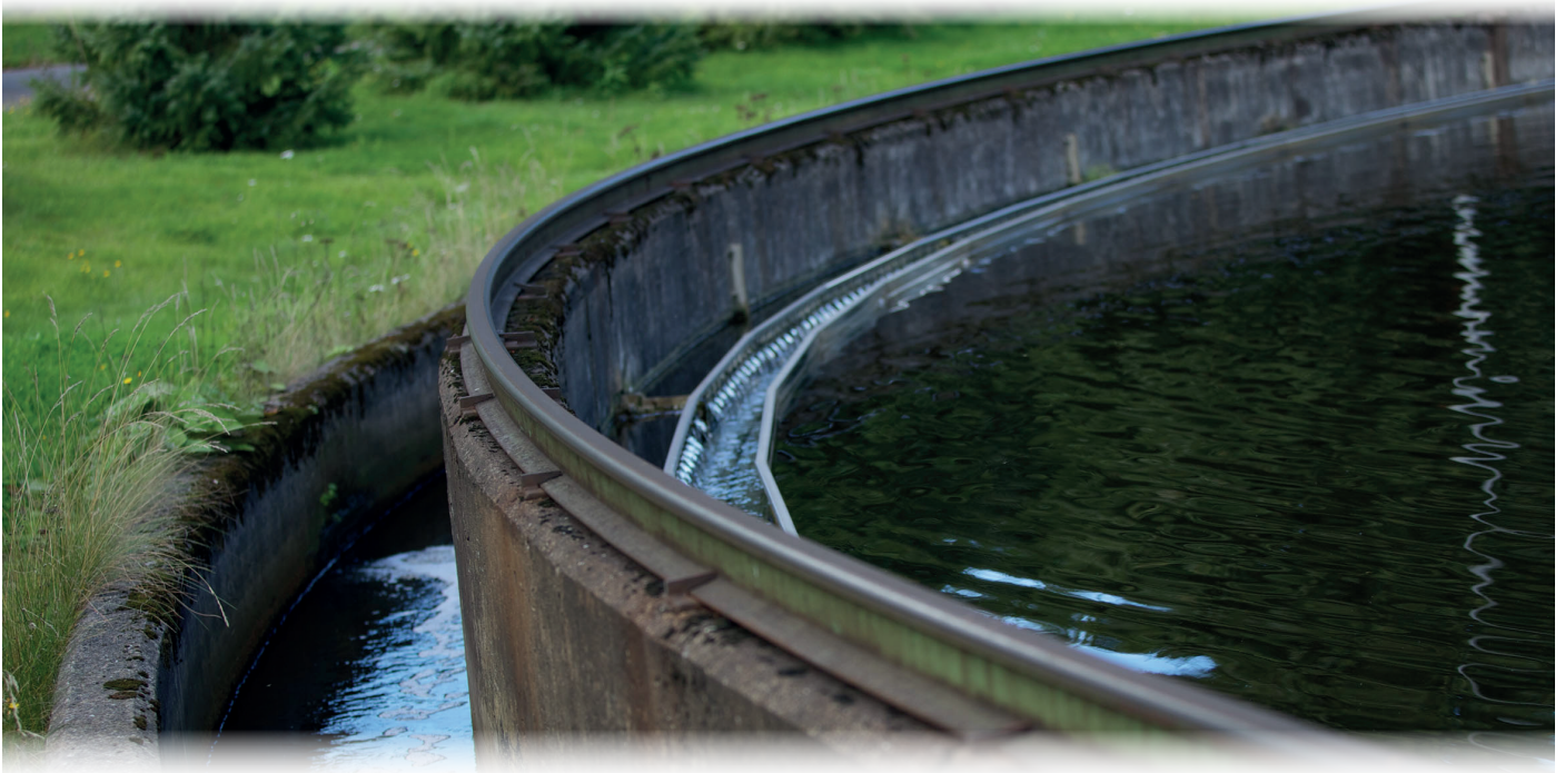
Kuva Toikansuon jätevedenpuhdistamo, Lappeenrannan Energia Oy.
