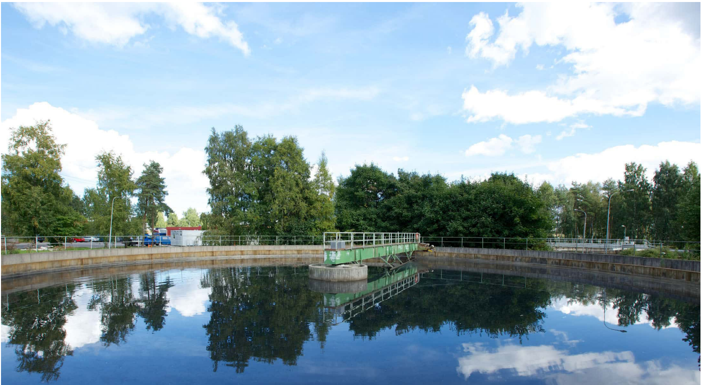
Kuva 13. Toikansuon jätevedenpuhdistamo, Lappeenrannan Energia Oy
