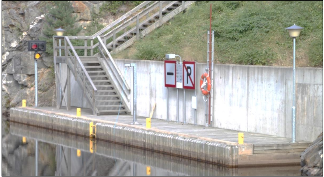
Kuva 18. Juankosken sulun sulutus käynnistetään vetämällä odotus-/asiointilaituriin asennetun tolpan narusta. Vastaavanlaista mekanismia voitaisiin hyödyntää myös Kutilan sulkuluukun avauksessa (FCG Suunnittelu ja tekniikka 8.8.2014).
