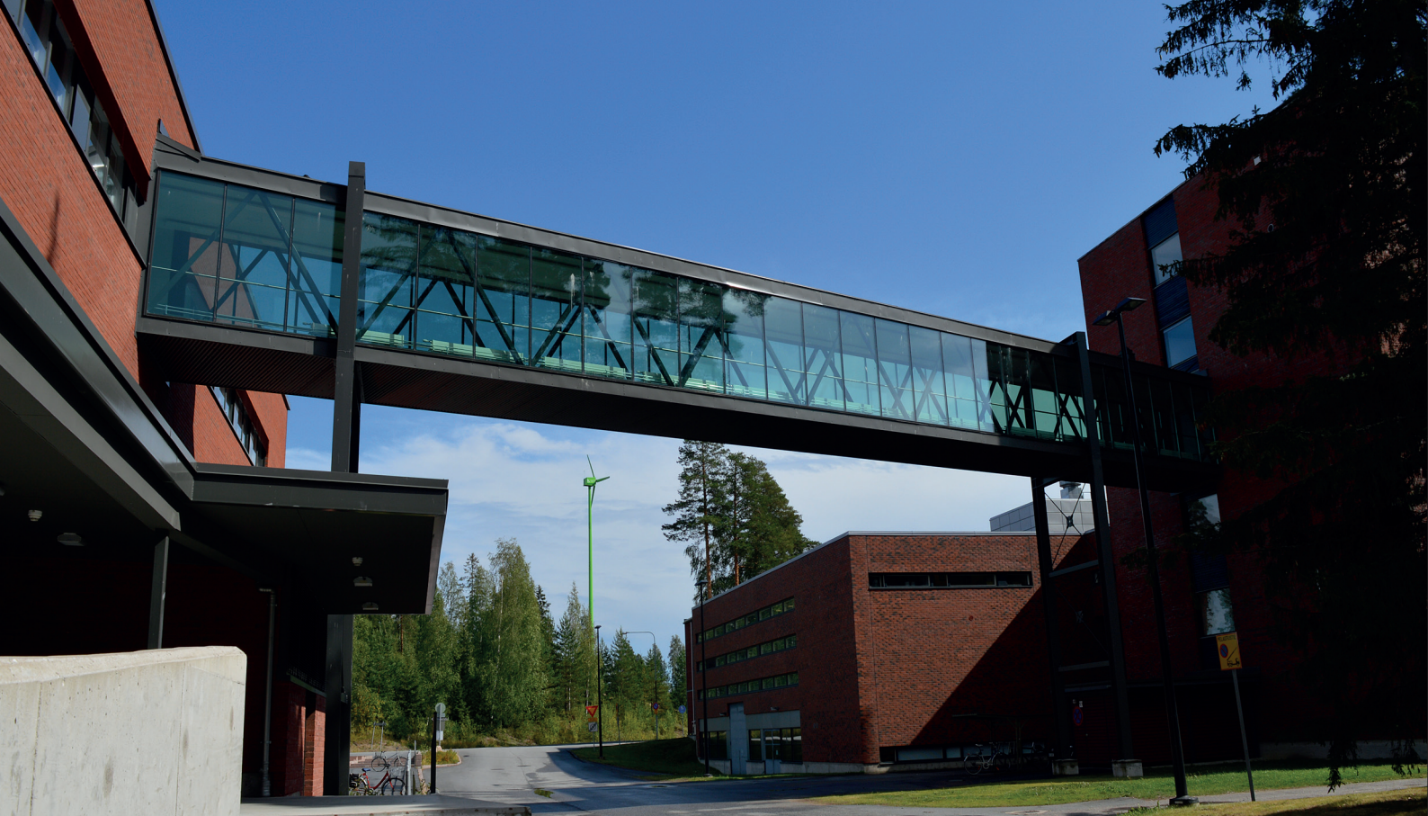
■ LAPPEENRANNAN TEKNILLISEN YLIOPISTON SEKÄ SAIMAAN AMMATTIKORKEAKOULUN VÄLINEN KÄVELYPUTKI KOETAAN TÄRKEÄKSI NIIN TOIMINNALLISESTI KUIN SYMBOLISESTIKIN. Kuva: Virve Lindström
