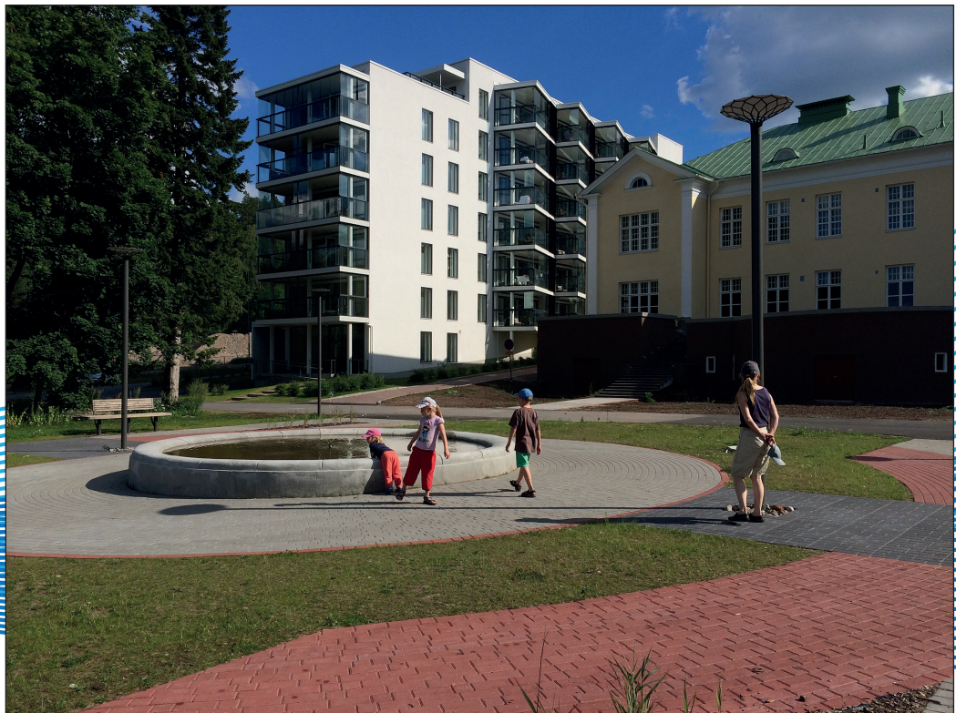
■ RAUHAN MILJÖÖSSÄ UUSI JA VANHA RAKENNUSKANTA MUODOSTAVAT NÄYTTÄVÄN KOKONAISUUDEN. Kuva: Atte Lindström
