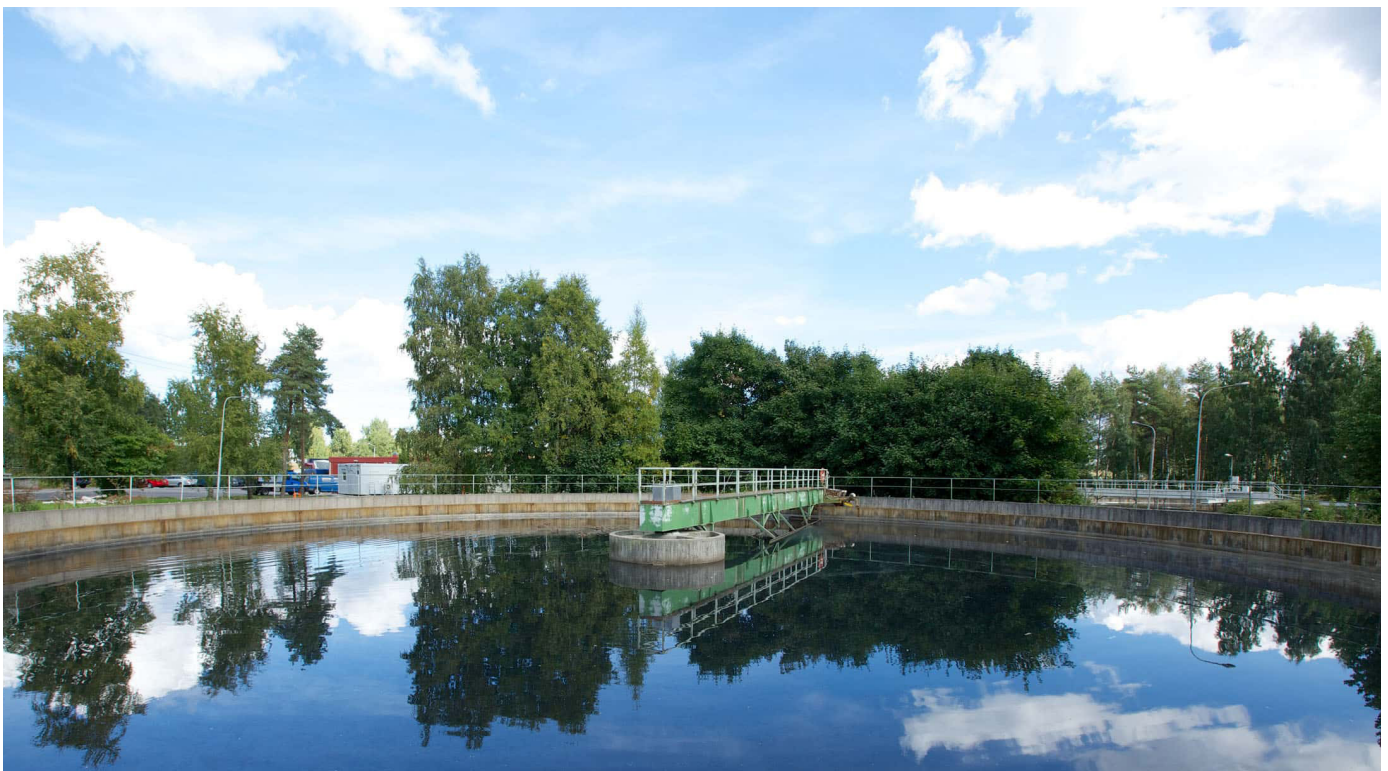
Kuva 10. Toikansuon jätevedenpuhdistamo, Lappeenrannan Energia Oy
