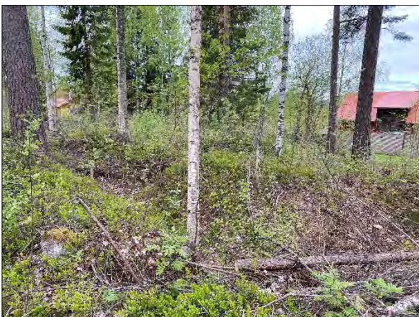
Kuva 475. Ruokolahti Maalinnoituskohde 3. Huonosti erottuva traverssi. Rakenteet ovat matalia ja sortuneita.
