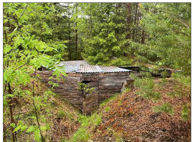
Kuva 393. Lemi Hatkanmäki. Yhdyshautaan on rakennettu maja. Etelästä.
