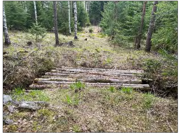
Kuva 69. Lappeenranta Uudenladonmäki-Rajakankaanmäki. Yhdyshauta, jonka läpi menee metsäautotie, on suojattu tukeilla.
