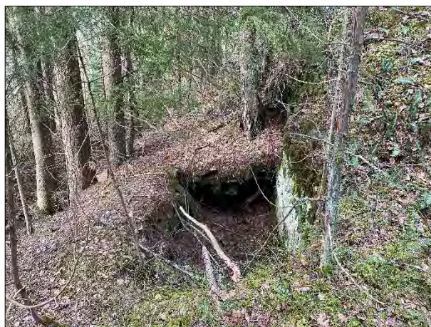
Kuva 16. Lappeenranta Sipilä 3. Katettu romahtanut rakenne kohteen länsiosissa. Kaakosta.
