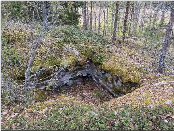
Kuva 109. Luumäki Ilves 2. Betonivahvisteinen asema. Pohjoisesta.
