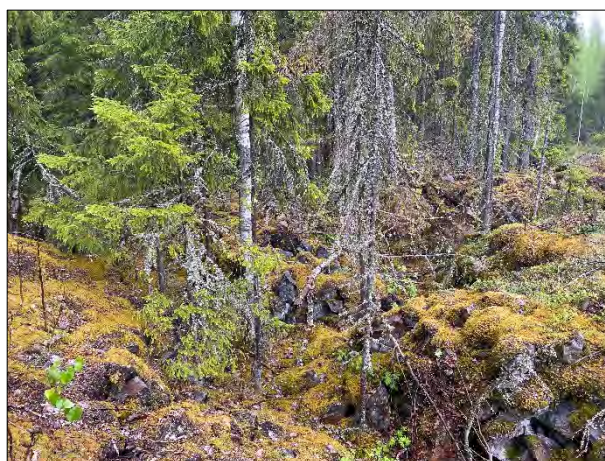
Kuva 426. Taipalsaari Kuukanniemi 7. Kivinen traverssi taisteluhaudassa. Rakenteet ovat osittain sortuneita ja mataloituneita. Kaakosta.
