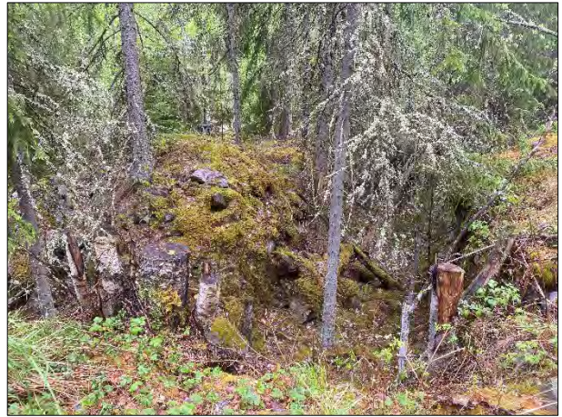
Kuva 435. Taipalsaari Kuukanniemi 9. Kohteen eteläpuolisen taisteluhautalinjan traverssi. Eteläpuoliset rakenteet ovat huomommin säilyneet kuin etummainen taisteluhautalinja. Idästä.
