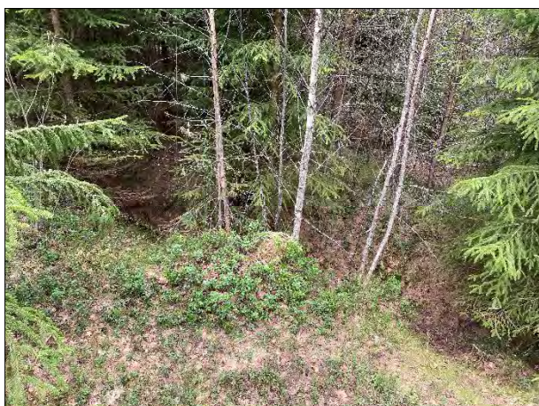
Kuva 486. Ruokolahti Maalinnoituskohde 9. Yhdyshautaa kohteessa. Rakenteet sijaitsevat erittäin tiheässä metsässä. Pohjoisesta.
