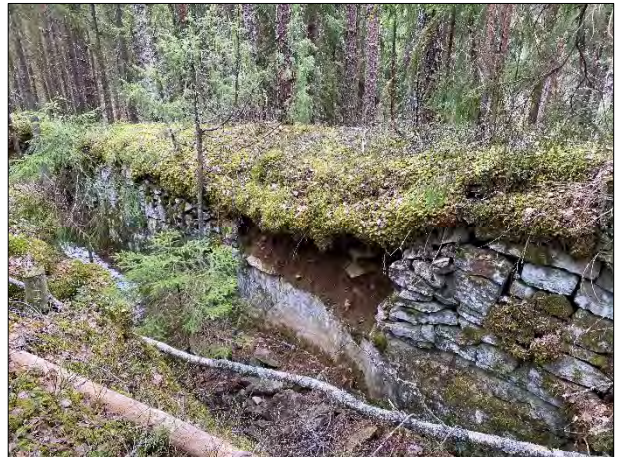
Kuva 119. Luumäki Kattilavuori. Taisteluhautaa, jossa kallion päälle on kylmämuurattu kivillä seinämiä. Pohjoisesta.
