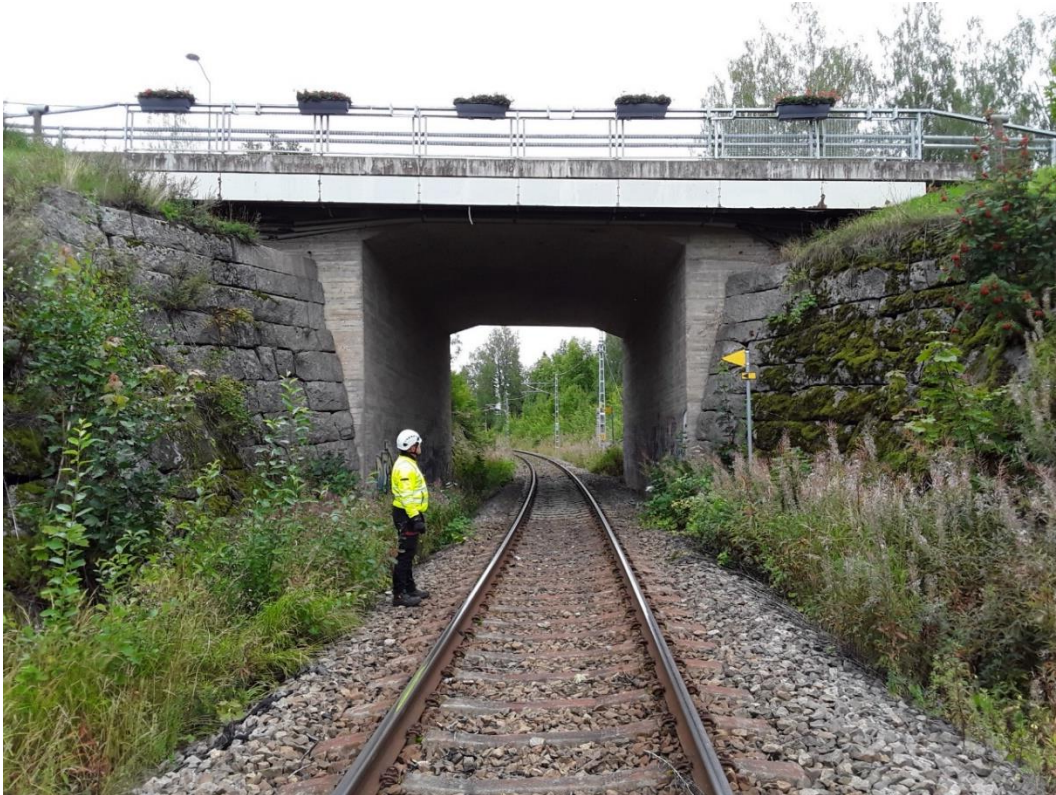
Kuva 18. Nk. Soihтусilta (vir. Kotakennään ylikulkusilta). Sähköistuksen päätepiste näkyy sillan takana (Väylävirasto n.d.a).
