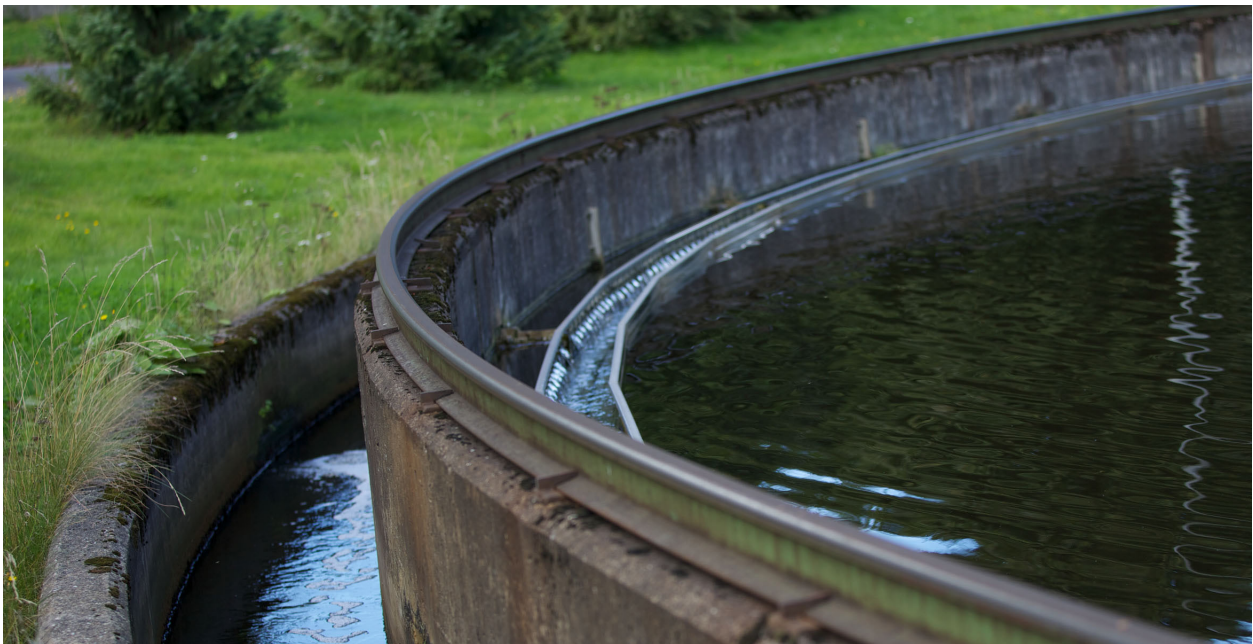
Kuva 17. Toikansuon jätevedenpuhdistamo, Lappeenrannan Energia Oy
