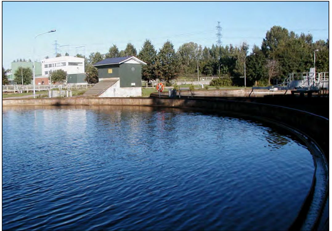
Kuva 14. Toikansuon puhdistamo, selkeytysallas.
