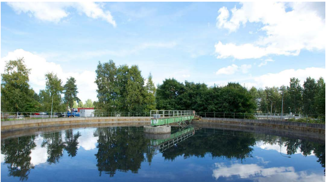
Kuva 10. Toikansuon jätevedenpuhdistamo, Lappeenrannan Energia Oy
