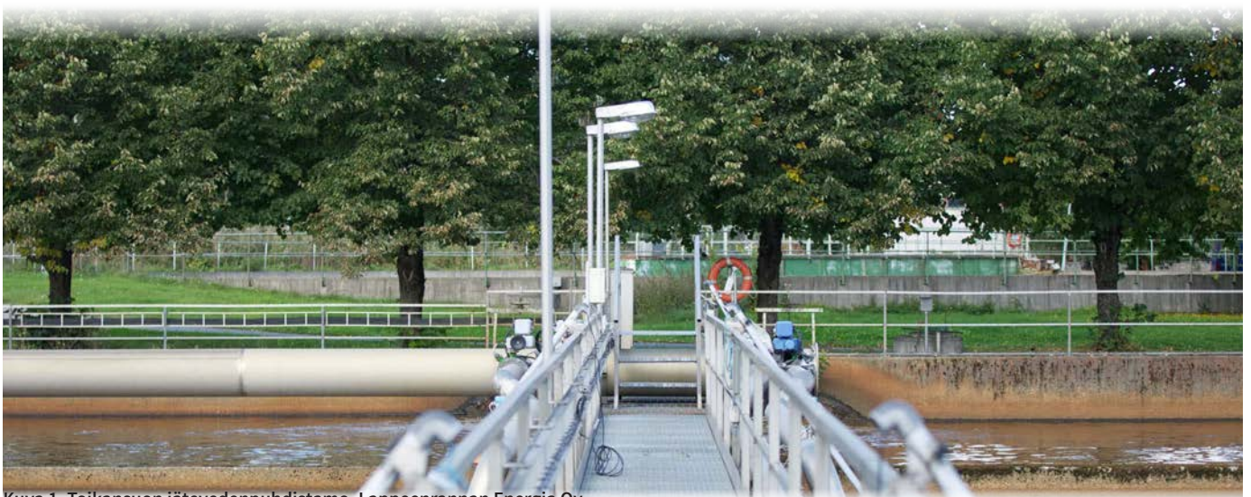
Kuva 1. Toikansuon jätevedenpuhdistamo, Lappeenrannan Energia Oy
